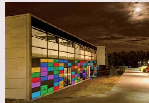
CENTER FOR HIGH PERFORMANCE FIBRE MATERIALS IN AKEN EEN BETON FAÇADE MET GEÏNTEGREERD LED-LICHT.
